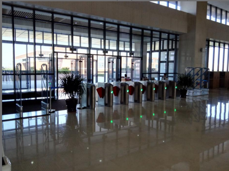
RFID+磁条智能双频防盗系统 南开大学新馆
